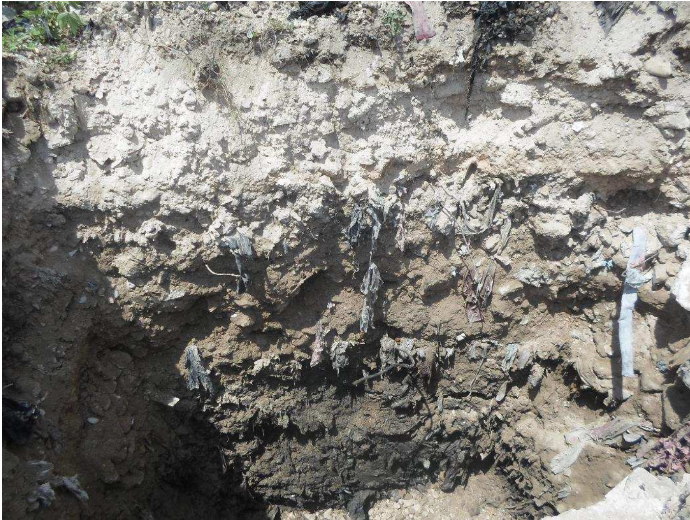
Sondage à la Pelle dans les remblais
